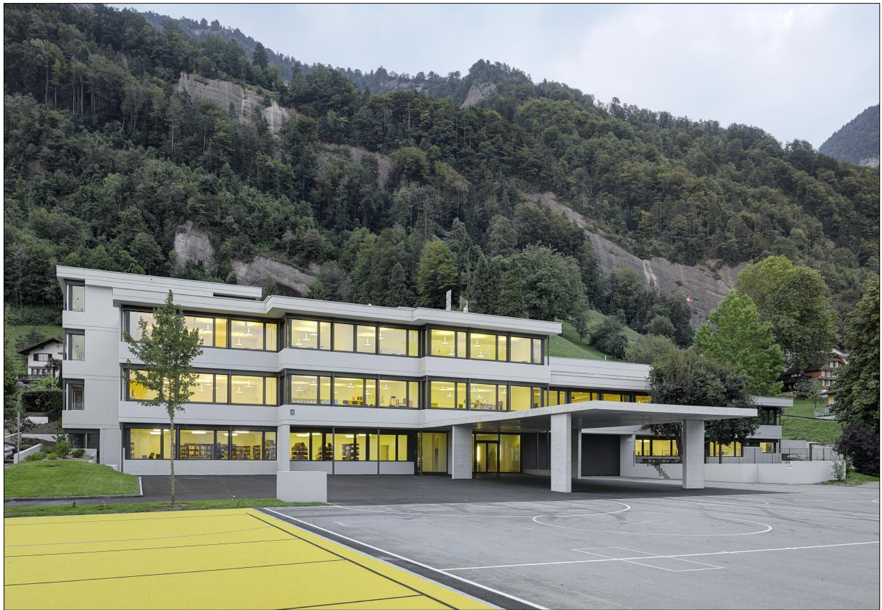
L'école primaire de Vitznau, rénovée par le bureau phalt. ROGER FREI
