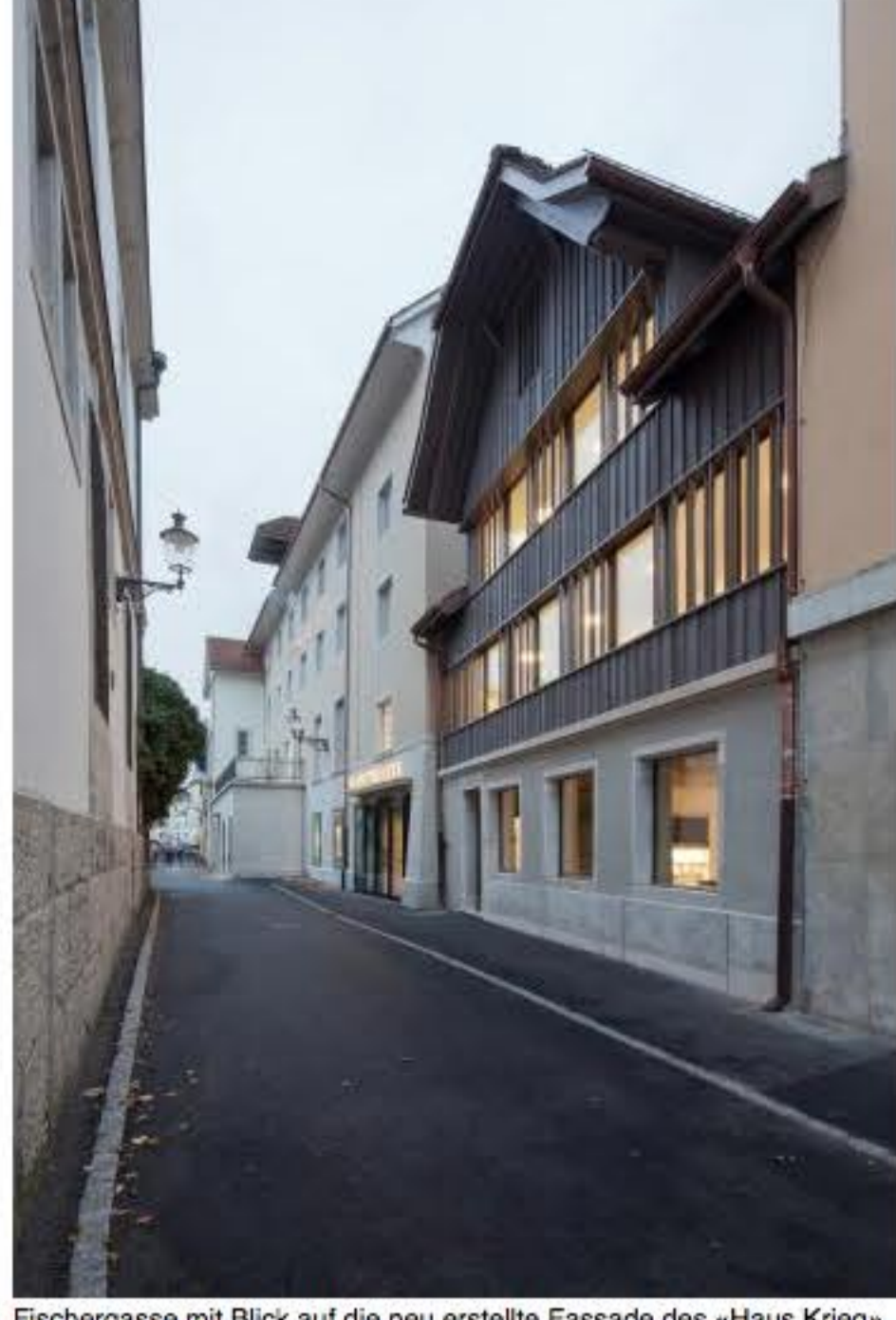
Fischergasse mit Blick auf die neu erstellte Fassade des «Haus Krieg» im Vordergrund
