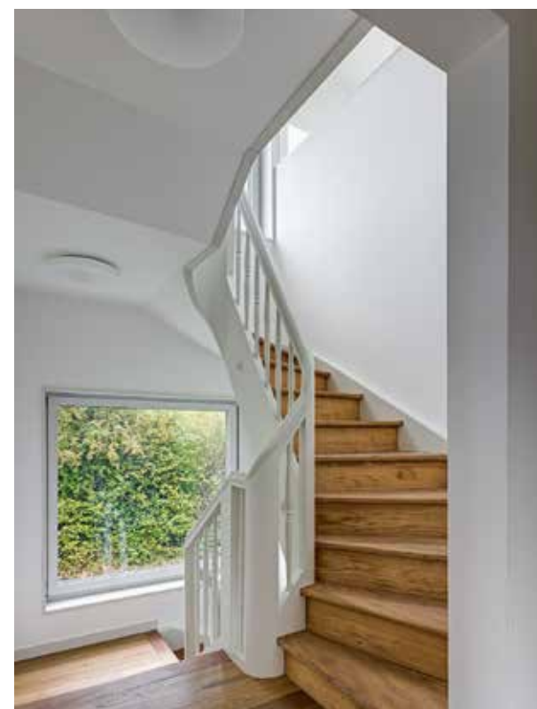
Die alte Holzstiege wurde sorgfältig restauriert und das Geländer im Bereich Ober-/Dachgeschoss originalgetreu ergänzt.
