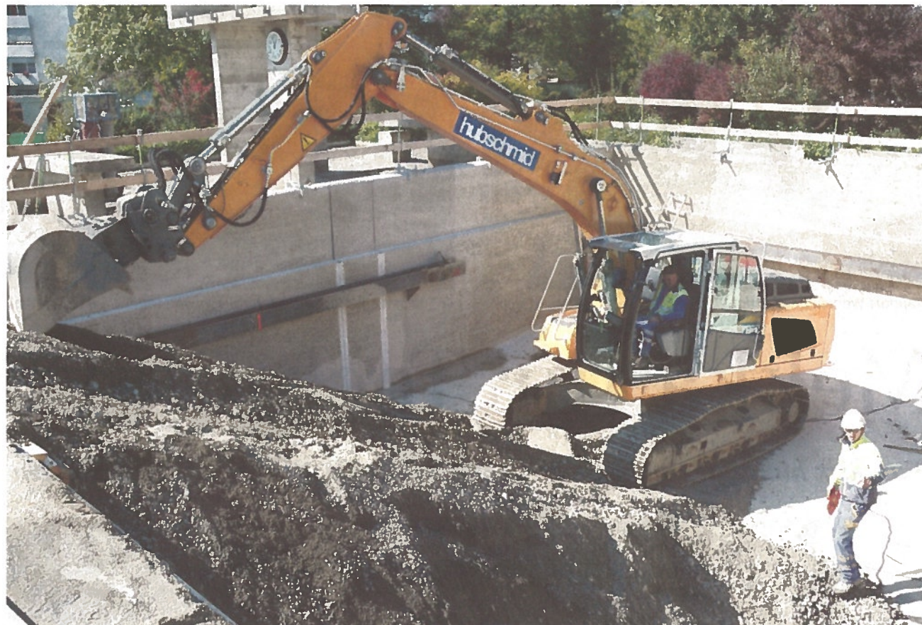
Der Bagger im Sprungbecken: Seit Anfang September laufen jetzt auch die Sanierungsarbeiten in der Badi auf Hochtouren – schliesslich muss die Anlage nächsten Sommer wieder benutzbar sein.
