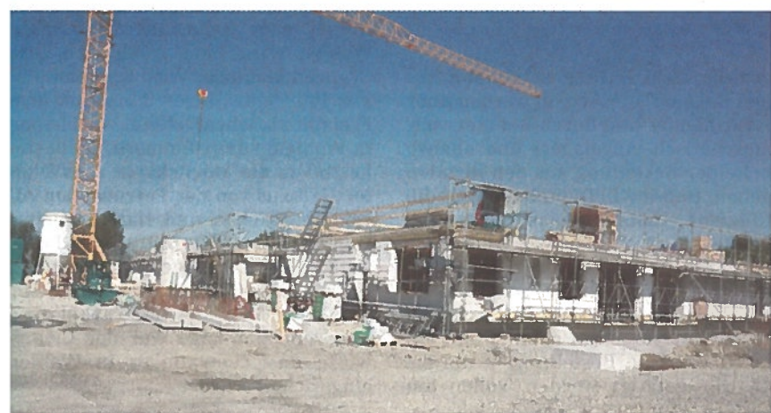
Die neue Eishalle nimmt immer mehr Form an. Schon bald wird die letzte Betondecke im einstöckigen Bereich erstellt, dann folgt der zweite Stock des Gastraums.
