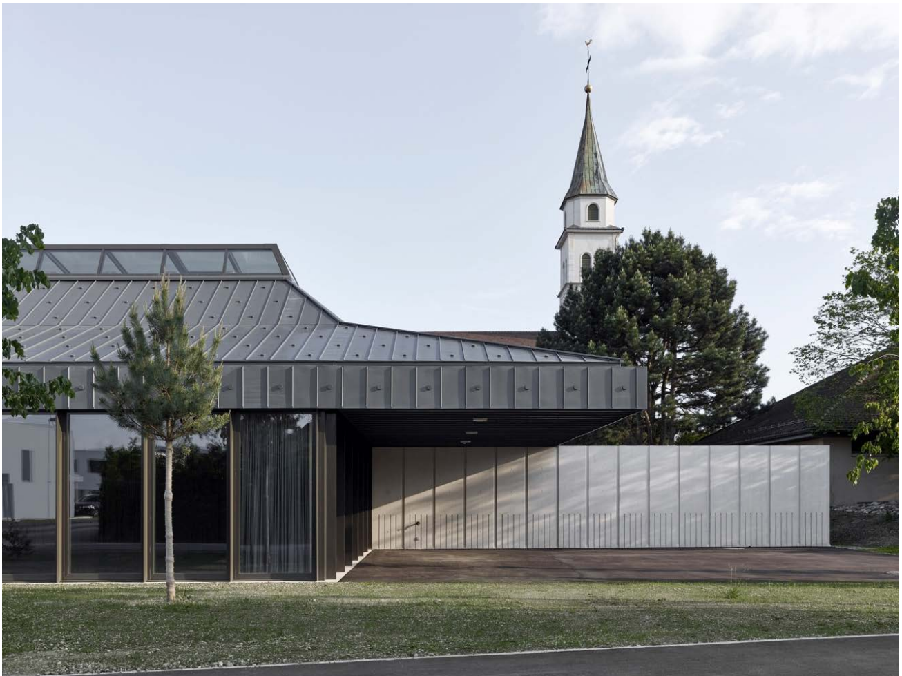
Neubau Pfarreiheim Kriegstetten Bauherrschaft: Römisch-katholische Kirchgemeinde Kriegstetten-Gerlafingen; Architektur: ern + heinzl Architekten, Solothurn.
