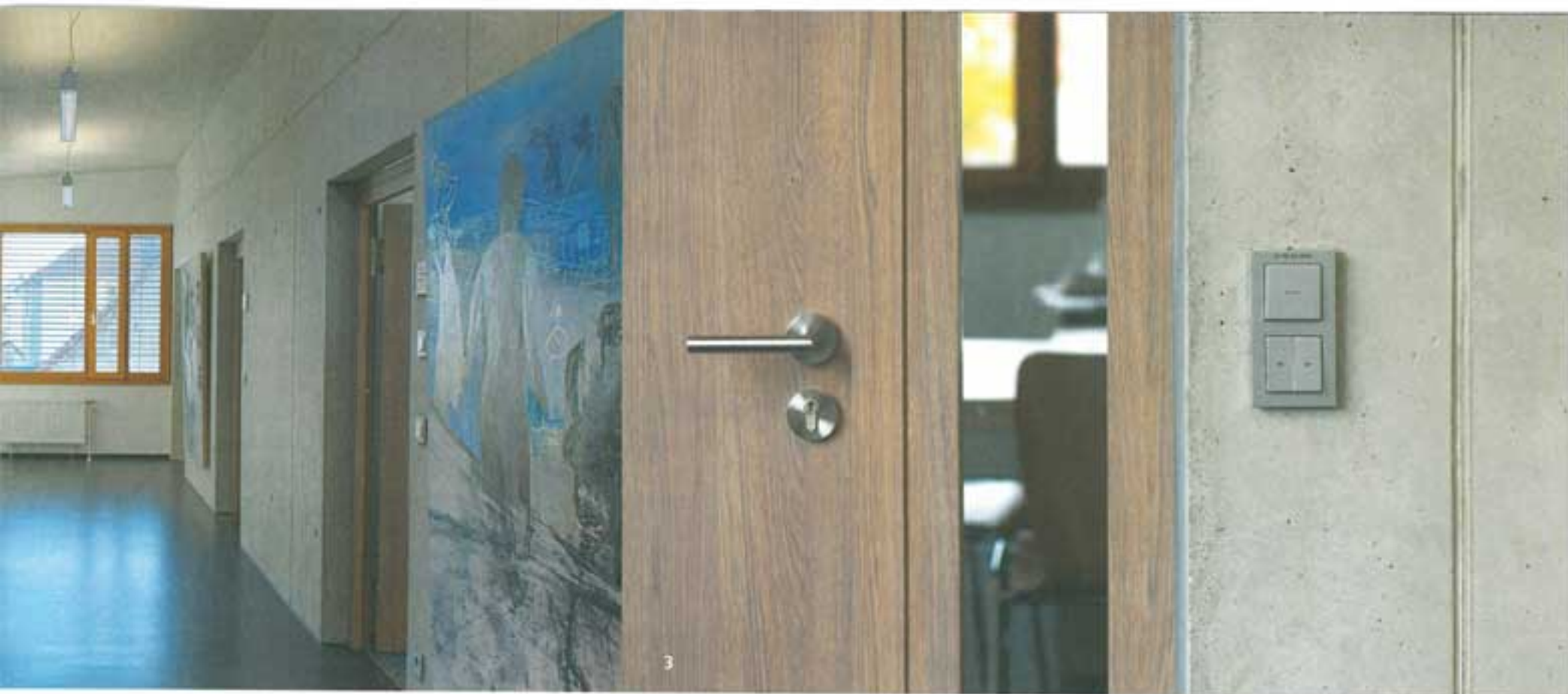
1-3 Die Polizeistation in Münsingen von Ulrich Schwille, Reutlingen, wurde in Sichtbetonklasse 2 ausgeführt.
